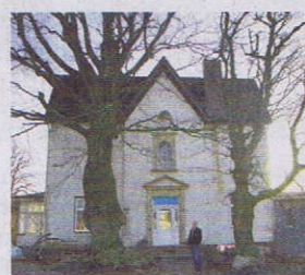
Die alte Villa wurde 1897 erbaut
